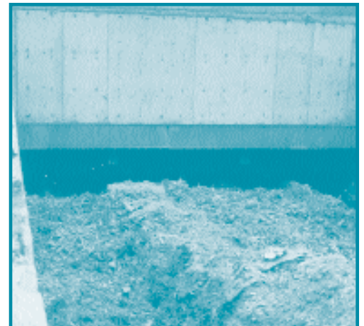
Réserve de biomasse à parois de béton
