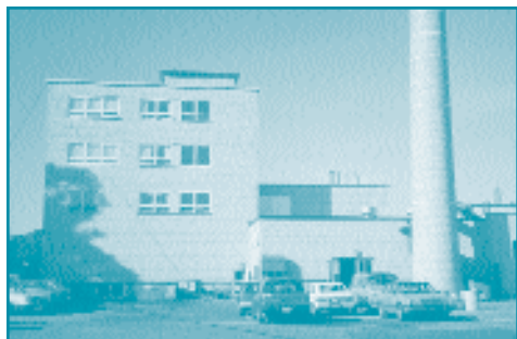
Cheminée de la maison pour personnes âgées Prince Edward Home de Charlottetown (Î.-P.-É.) - Chauffage centralisé, 1985
